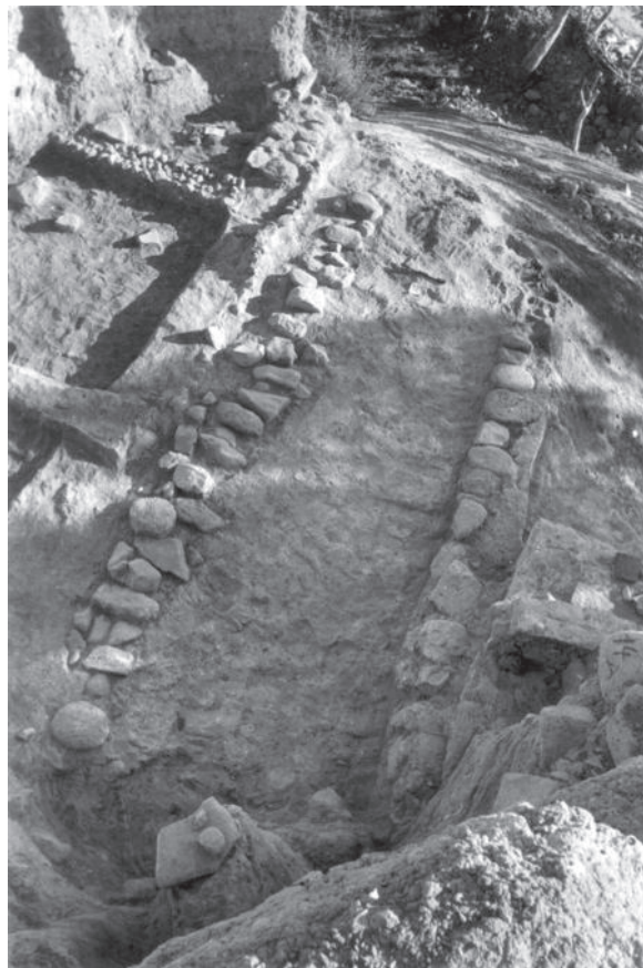
איור 3. הבתים בשטח BS בשלב הקדום, לפני סלילת הרחוב, מדרום. שורת הלוחות זוהתה בידי החופר כשביל, אך אפשר שמדובר באבני שפה של הרחוב בשלבו הקדום
